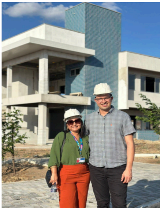
Figura 22 - Visita à obra do futuro prédio da BCCR
